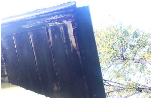
Abbildung 4: Dachvorsprung aus Holz mit größeren Löchern
