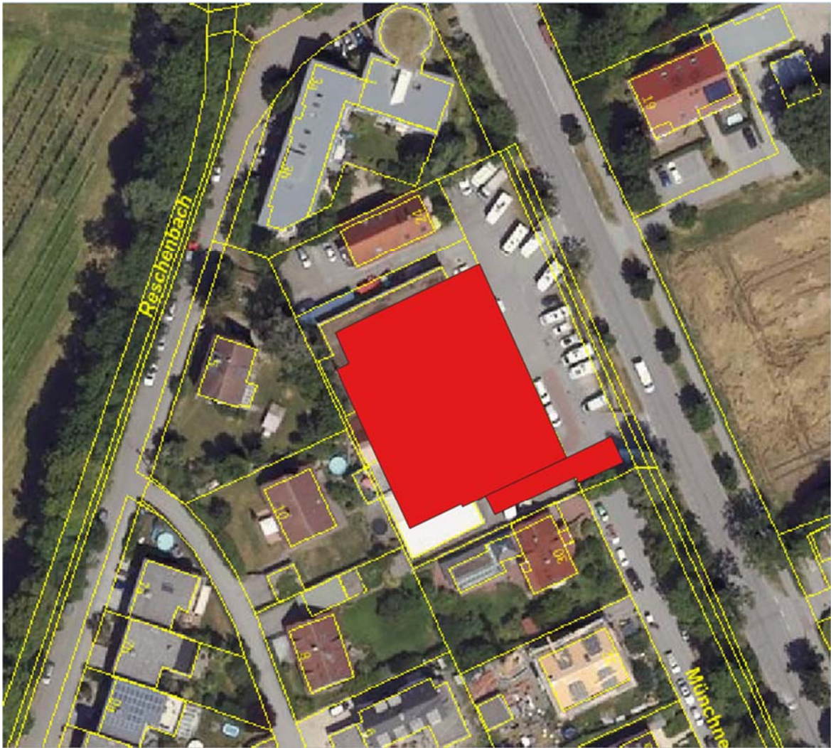
Abb. 2: Gebäudesymmetrie im ersten Berechnungsfall. Die Tiefgaragenzufahrt befindet sich im Süden des Gebäudes. Diese Darstellung ist eingenordet und nicht maßstabsgetreu. © Orthofoto: Bayerische Vermessungsverwaltung.
